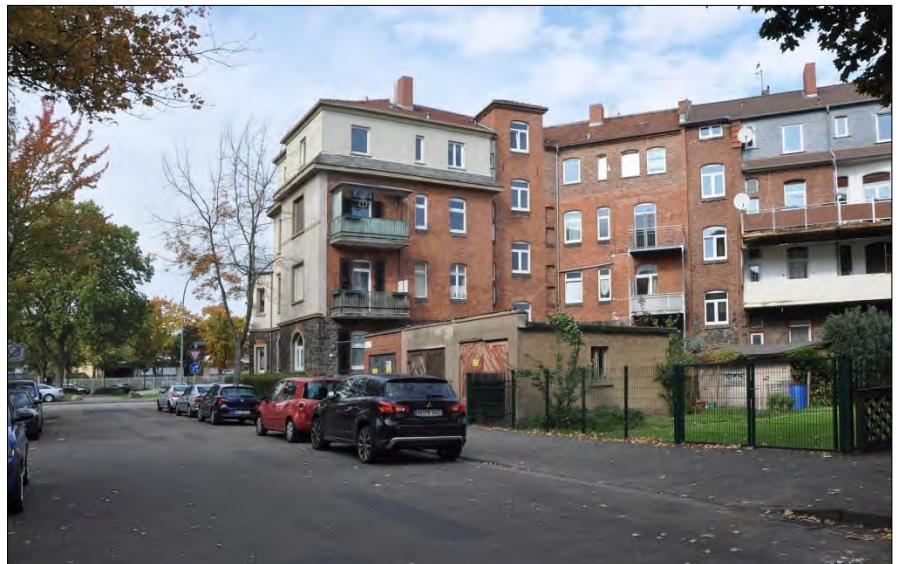
Blockrandbebauung Leipziger Straße, Hofseite
