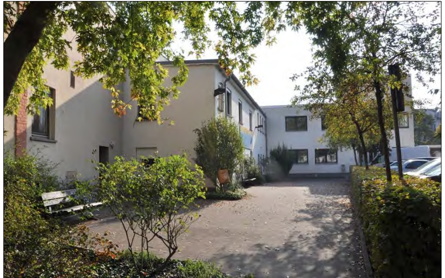
Stadtteilzentrum Südost, Vorbereich
