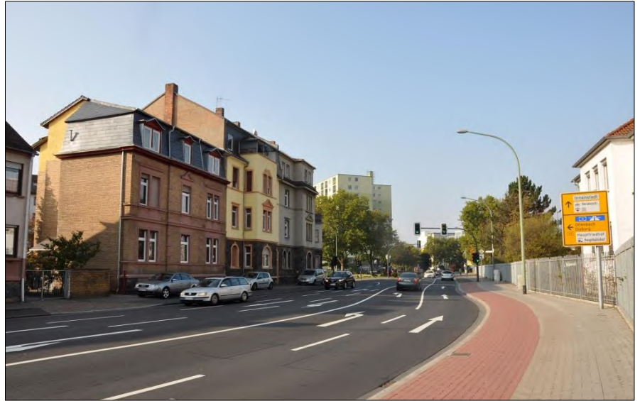
Blockrandbebauung Leipziger Straße, Straßenseite
